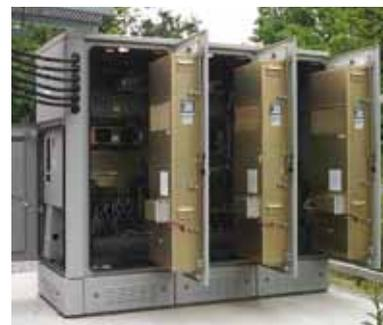
Корпуса для аккумуляторных батарей и вспомогательного оборудования питания. Установка дополнительных секций для выполнения требований к мощности за счет модульной конструкции; регулировка микроклимата для обеспечения максимального срока службы оборудования и батарей; экранирование для защиты от электромагнитных и радиопомех, отдельные отсеки для щитов с выключателями, а также системы организации кабелей.
